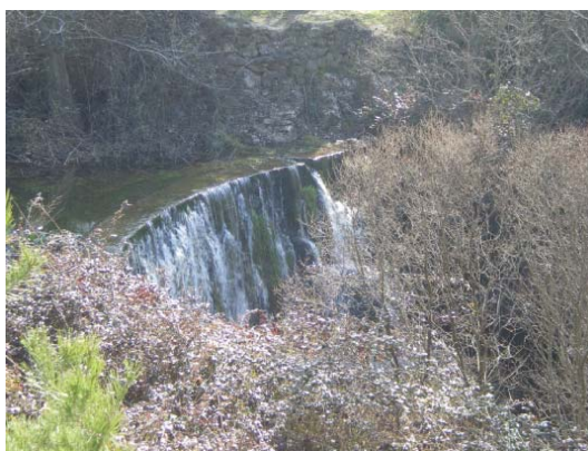
Foto 5: Azud Fuente del Sapo, infranqueable para la fauna piscícola
