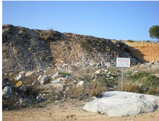
Foto 1: Escombrera junto al azud de Be-neixama
